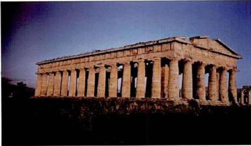
FIGURA 12.11 As lajes horizontais de rocha do teto não podem resistir por muito tempo, pois a rocha rompe facilmente sob tensão. Eis a razão da necessidade de tantas colunas para sustentar o teto.
