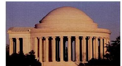
FIGURA 12.14 O peso da cúpula produz compressão, não tensão, de modo que não são necessárias colunas de sustentação na parte central do prédio.
